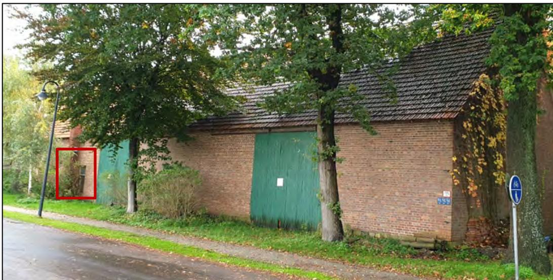
Bild 9: Blick von der Jahnstraße auf den Stallteil „Lager“ (rot eingekreist Lüftungsgitter der Getreidetrocknungsanlage, ca. 0,85 m x 2 m)
