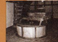
Schon 1910 hatte der Colon Anton Overmeyer gt. Wichmann das Wasserrad der Kornmühle durch eine Francis-Turbine ersetzen lassen. Seitdem wurde die Mühle über Transmissionsriemen angetrieben. Auch setzte man seit 1928 in trockenen Sommern, wenn die Aa nicht ausreichend Wasser führte, eine Dampfmaschine ein. Diese wurde 1935 durch einen Petroleummotor ausgetauscht. Nachdem 1938 die öffentliche Stromversorgung erfolgte, wurde er durch einen 15 PS starken Elektromotor ersetzt.
